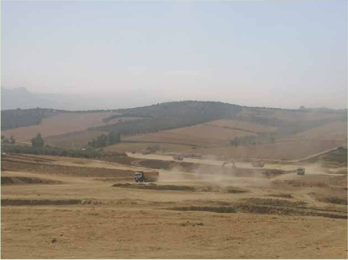
Dikmece Mahallesi, kamulaştırılan tarım arazilerinde TOKİ inşa çalışmaları, Eylül-2023, Demet Bolat
