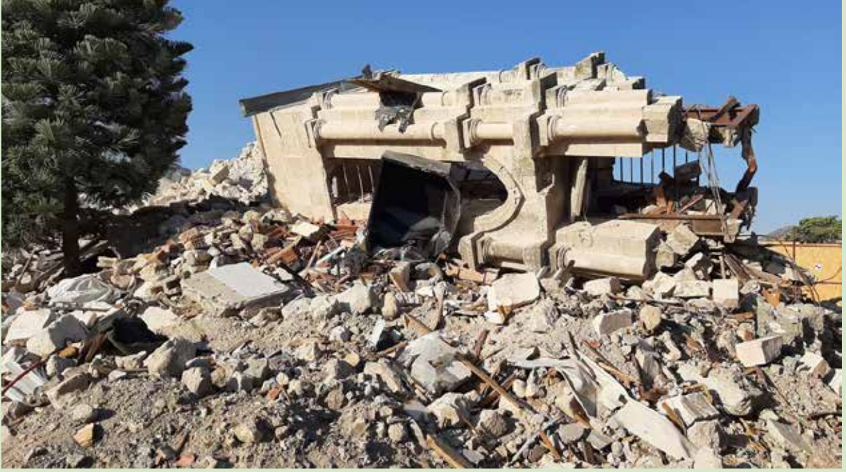
Antakya merkezi, Ortodoks Kilisesi, yıkılmış çan, Eylül-2023, Şafak Aykaç
